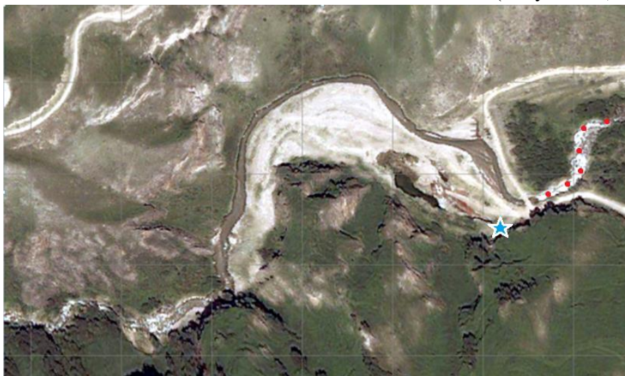
Рисунок 17. Участок русла р.Гижгит перед входным порталом тоннеля (синий маркер). Течение реки слева направо. Красный пунктир - действующее на момент съемки русло, отводящее сток в озеро Гижгит через аварийный лоток в теле плотины под автомобильным мостом. Снимок QuickBird от 21 июля 2007 г., изображение взято с Google Earth Pro TimeLapse. Шаг сетки 100 м.
