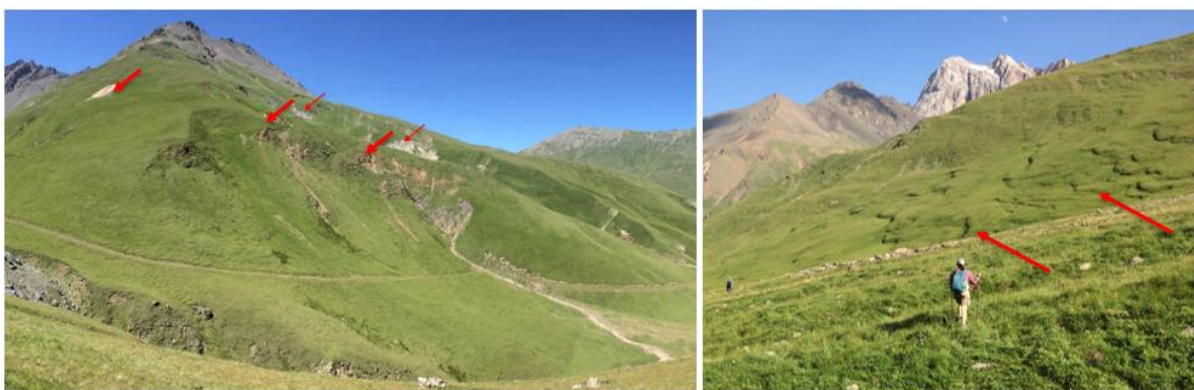
Рисунок 7. Слева: линейно вытянутые участки активизации склоновых процессов, приуроченные к зонам разрывных нарушений в бассейнах № 34 и 35. Справа: нижние части склонов правого борта в верховьях долины Гижгита подвержены процессам массового смещения рыхлообломочного чехла по механизму солифлюкции.
