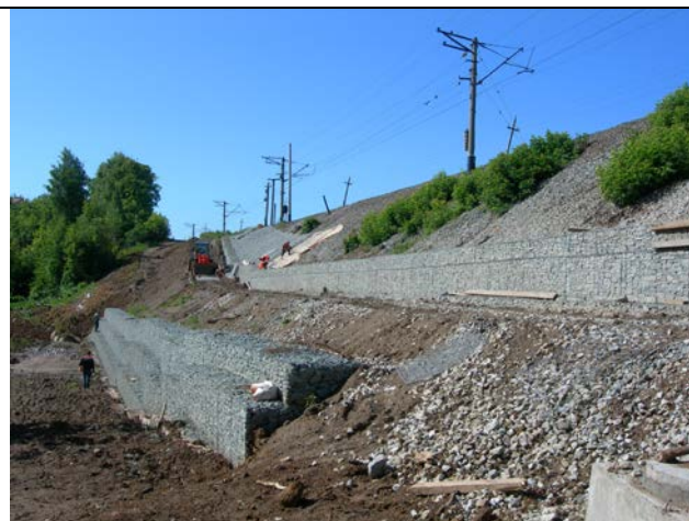
Фотография насыпи с усилением габиоными конструкциями
