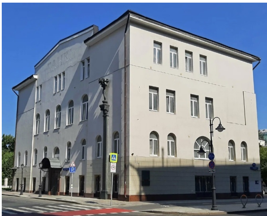
Рис. 2.9. Здание на улице Пятницкой 70/41 (ноябрь 2024)
